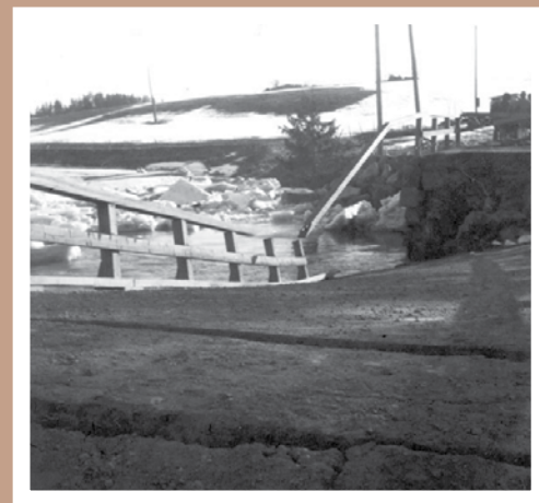
Kerkkoon kivisilta oli sortuneena surkea näky. Kuva kyläpuoleiselta rannalta.
