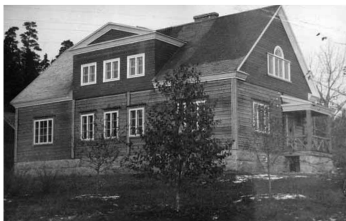
Hannulan talo on rakennettu 1900-luvun alussa. Se on säilynyt ulko- näöltään lähes alkuperäisenä. Yläkuvassa Hannulan talo vuonna 1919, alakuvassa talo vuonna 1924. (Satu Lampinen)
