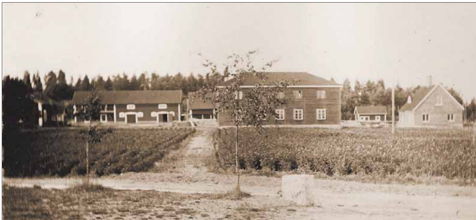
Lampisen suksitehdas 1920-luvulla: rakennuksesta piti tulla tilan uusi asuinrakennus, mutta se otettiin heti valmistuttuaan suksitehtaan käyttöön. (Kerkkoon Nuorisoseuran Kotiseutukuvasto I)
